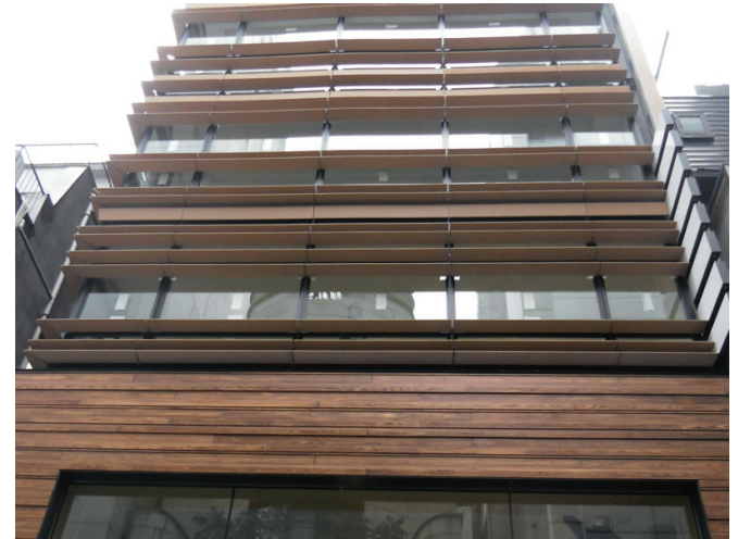
銀座すずらん通りにオープンするアンテナショップしあわせ信州シェアスペースの工事現場を視察する。
